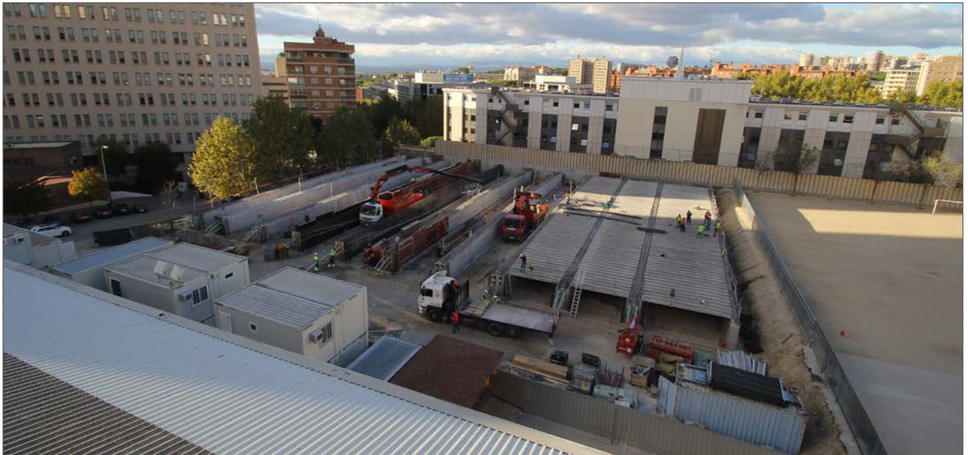
Vista del inicio de la construcción del Polideportivo
