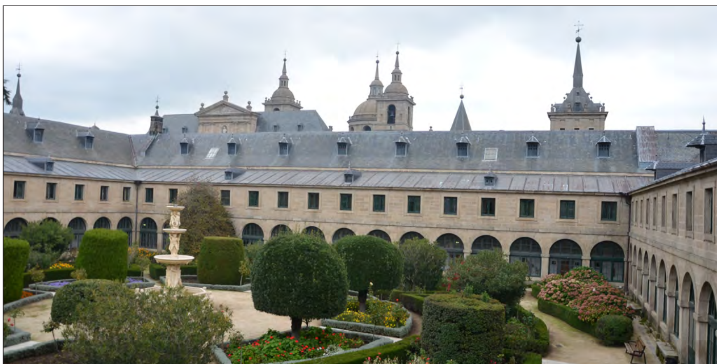
Vista del patio central del real Colegio Universitario María Cristina.
